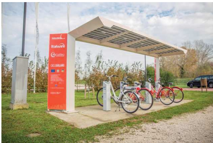
Pensilina fotovoltaica con relative biciclette elettriche
